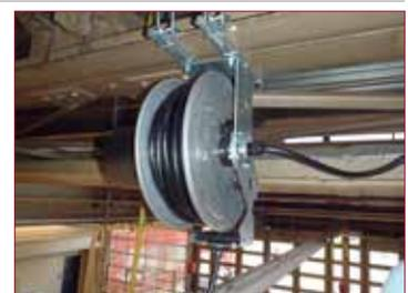
**Für Druckluft, Wasser (max. 120°C), bis 10 bar**
